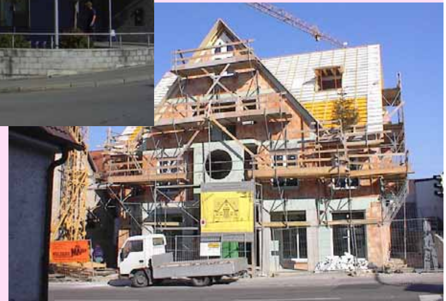
Planung und Bauphase Neubau 2001 - 2003
